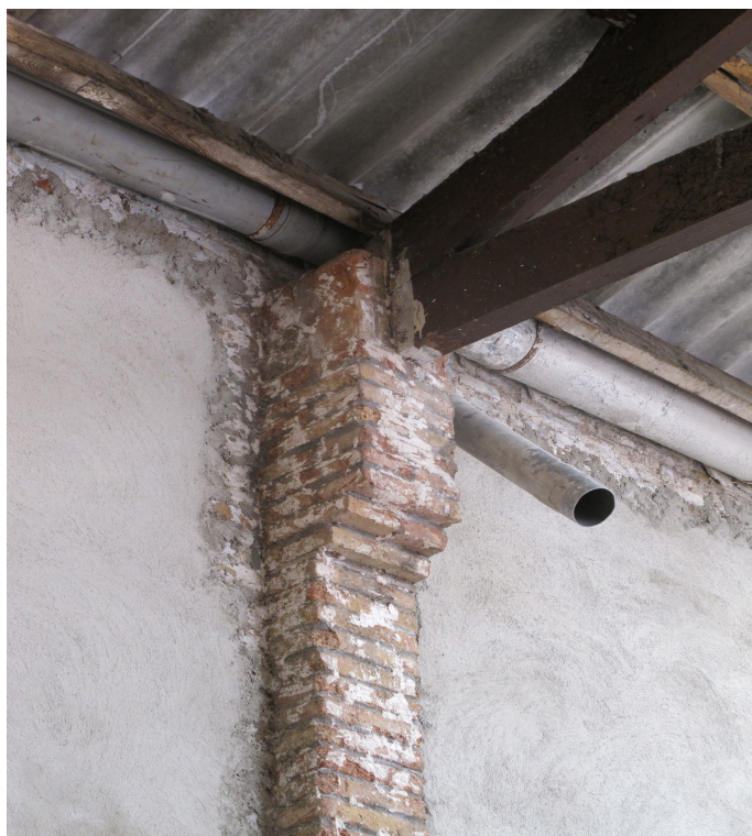
Fig. 1. Detall d'un pilar adossat en el que podem veure que està lligat amb ciment i presenta els maons esglaonats a la part superior.
